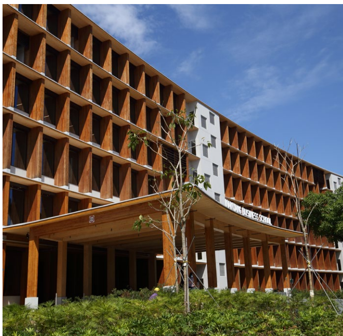
Foto: Steeltech Industries PTE Ltd.
